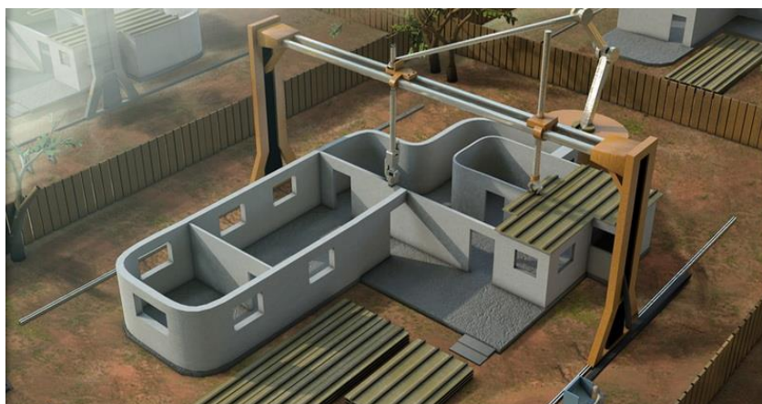
Рис. 1. Макет процесса контурного строительства
